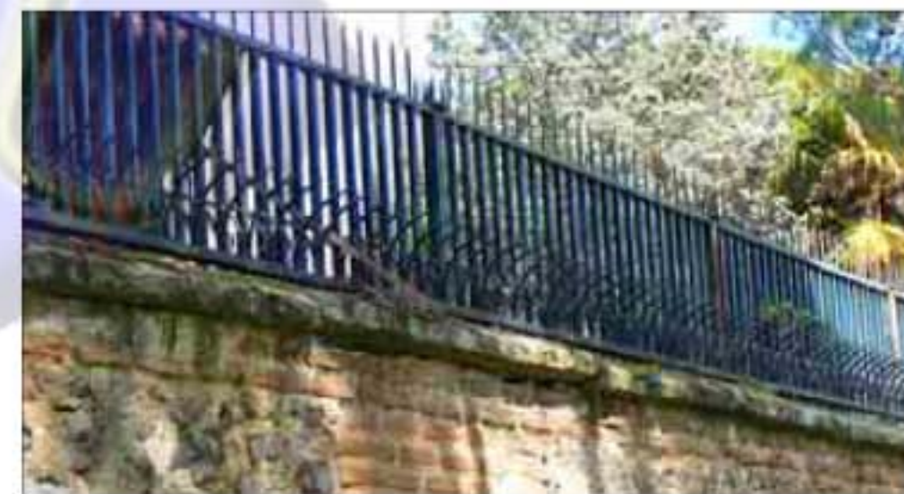
Tapia histórica de la Casa de Campo con una valla. / PLATAFORMA C. CAMPO
